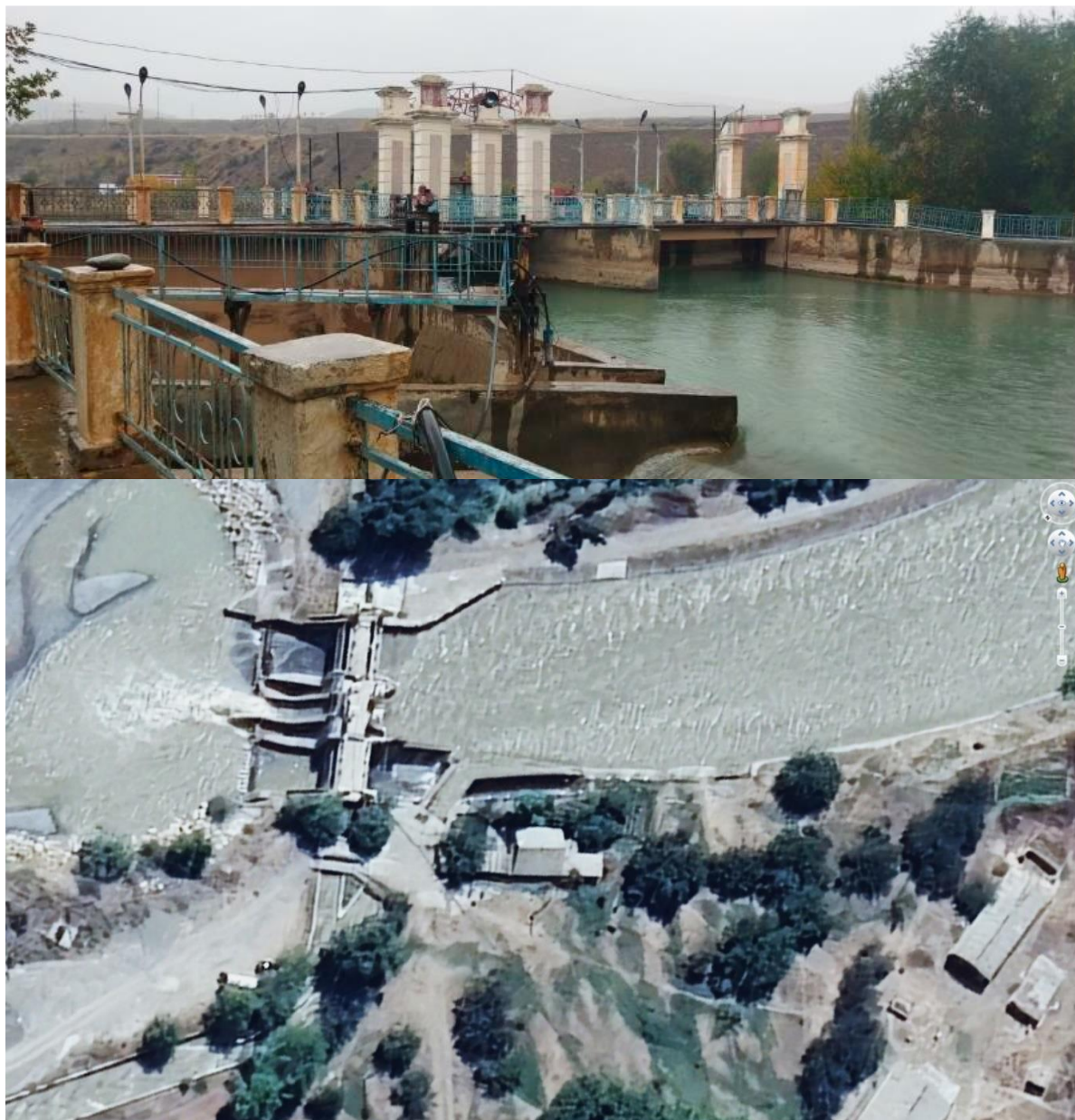
Рисунок 2. Головное водозаборное сооружение ПК0+00
