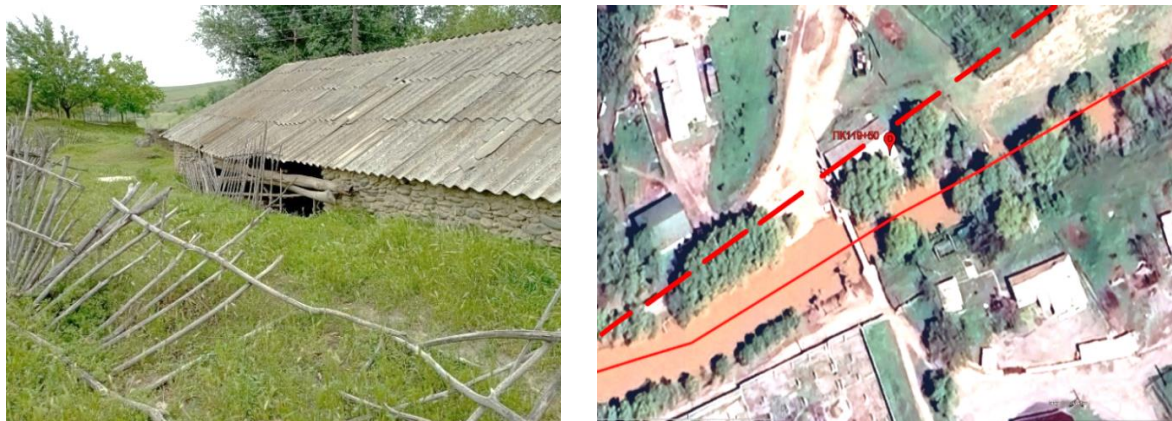
Рисунок 6. Участок канала Отуз-Адыр ПК119+00
