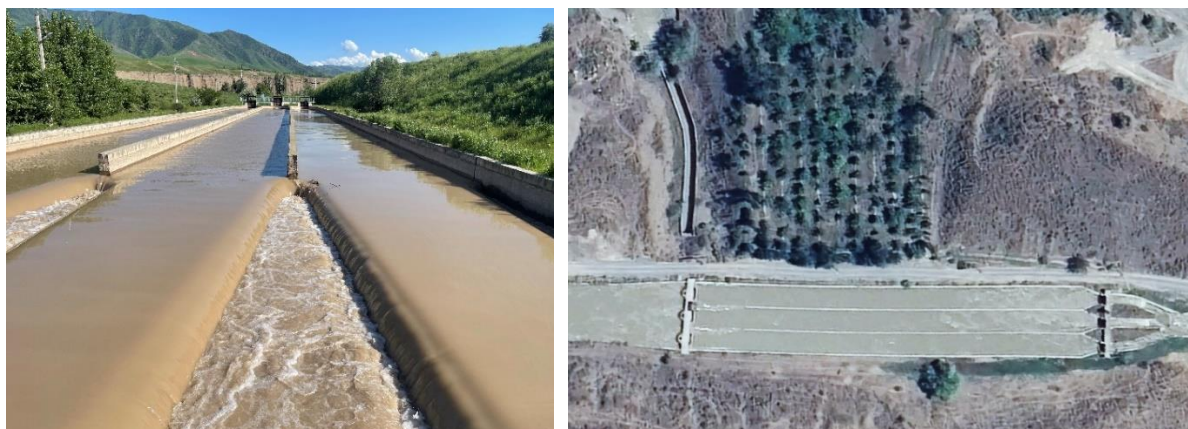
Рисунок 3. Трехсекционный отстойник ПК2+50
