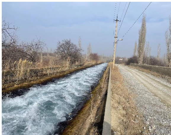
Рисунок 2. Текущее состояние МК Нургазиев
