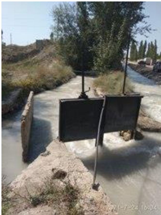
Рисунок 7. Водовыпуск на ПК144+39 (Отвод в канал Алга)
