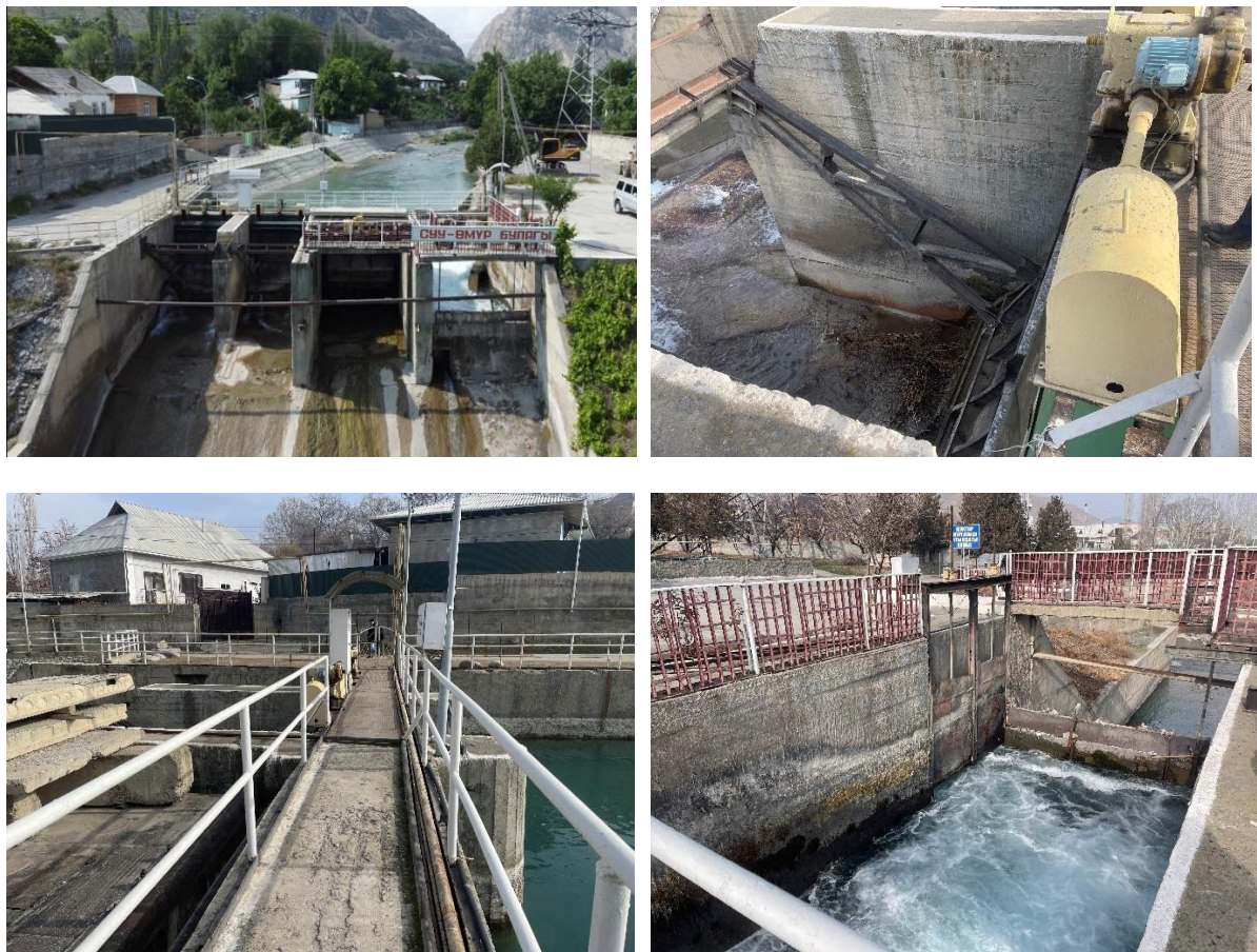
Рисунок 5. Головное водозаборное сооружение
