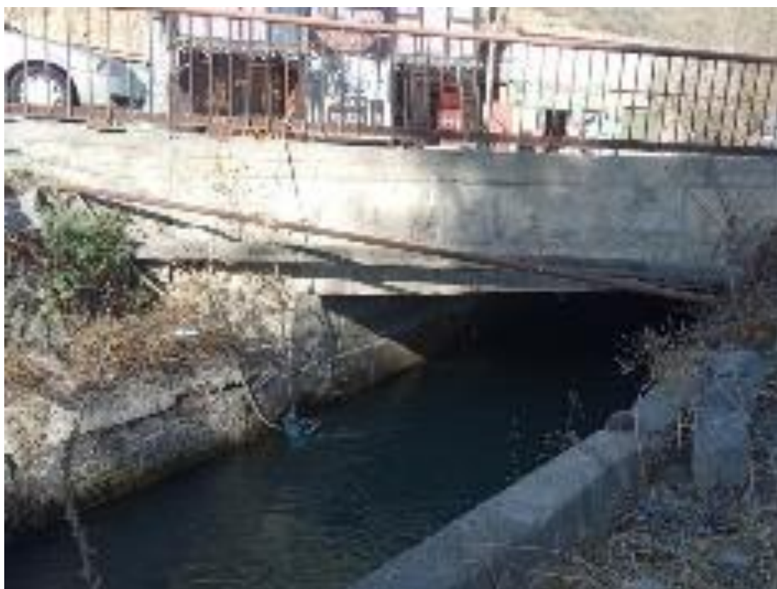
Рисунок 9. Автодорожный мост на ПК18+12
