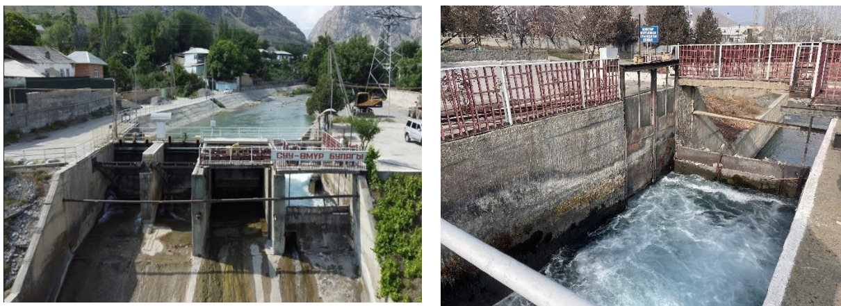
Рисунок 4. Головное водозаборное сооружение.
