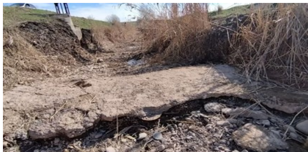
Изображение 12. Труба под каналом, вид сверху из канала
