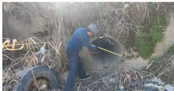
Изображение 13. Труба под каналом, вид снизу из канала
