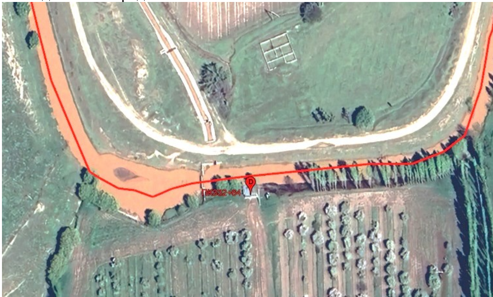
Рис. 21. Насосный навес на ПК332+64 на канале «Отуз-Адыр».
