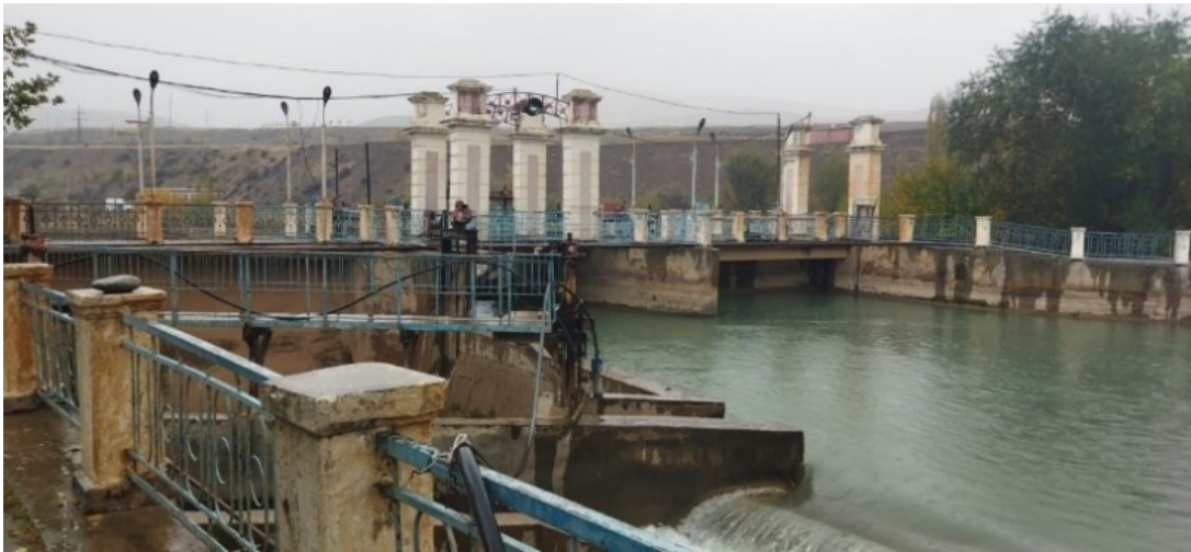
Рис 4. Головное водозаборное сооружение.
