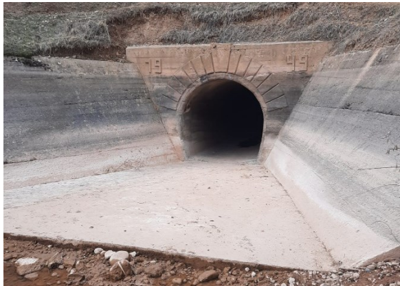
Рис 15. Входной портал действующего туннеля
