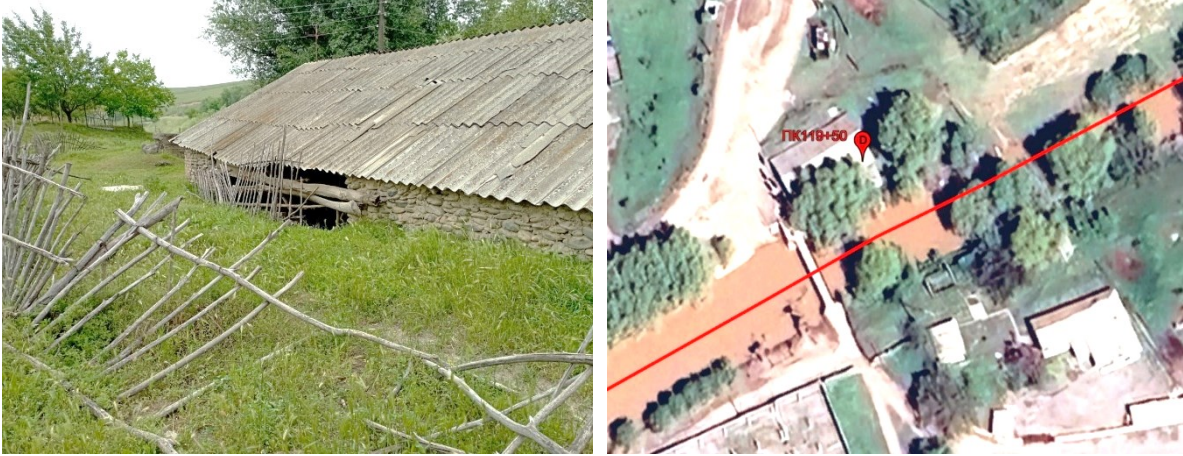
Рис. 20. Канал «Отуз-Адыр», участок ПК119+00
