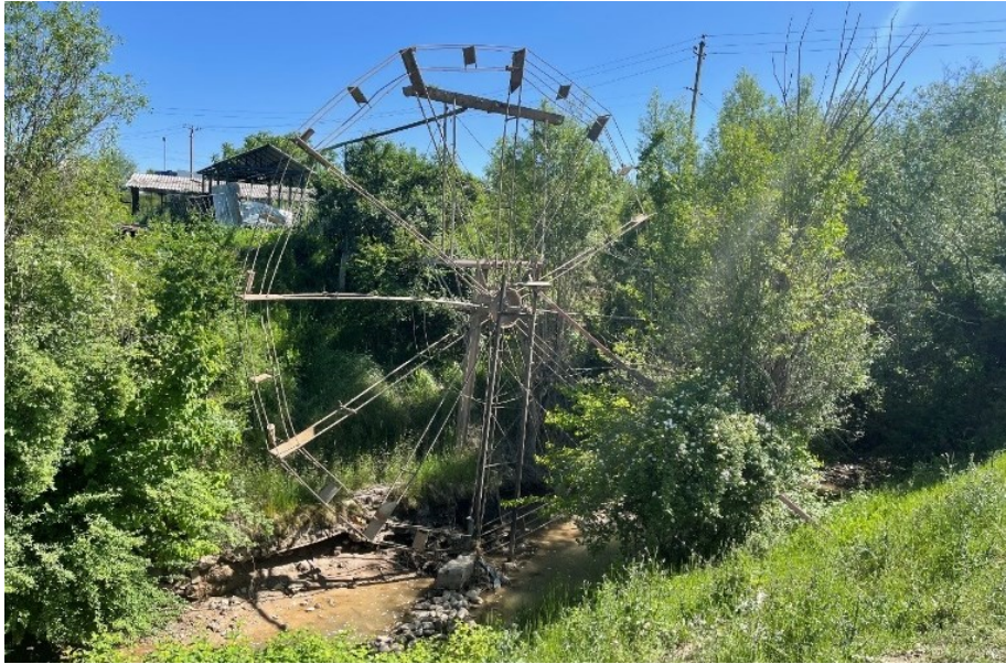
Рисунок 22. Старое водяное колесо на ПК399+40 на канале «Отуз-Адыр»».
