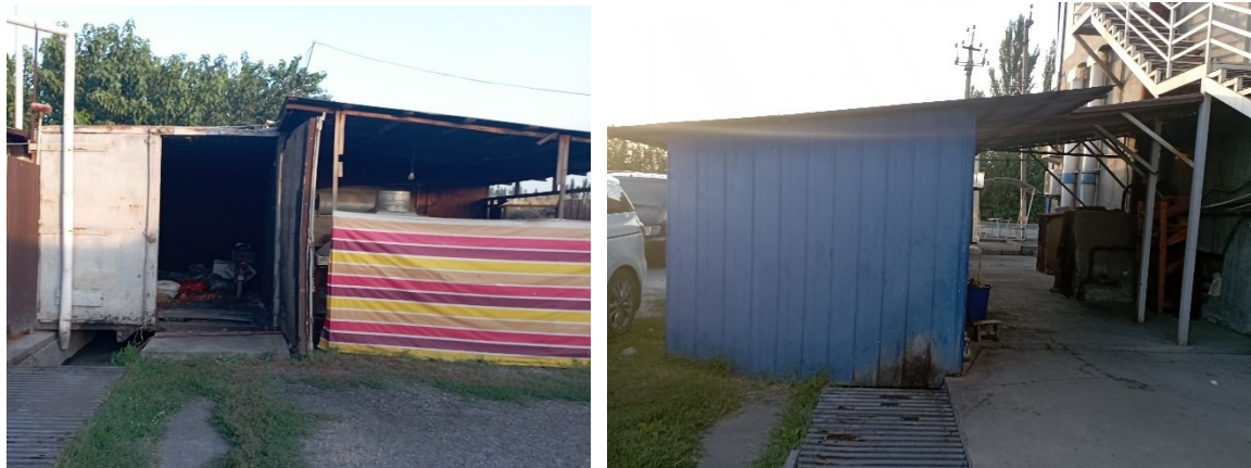
Изображения 24 и 25. Участок канала «МКС» от ПК8+00 до ПК ПК8+70.
