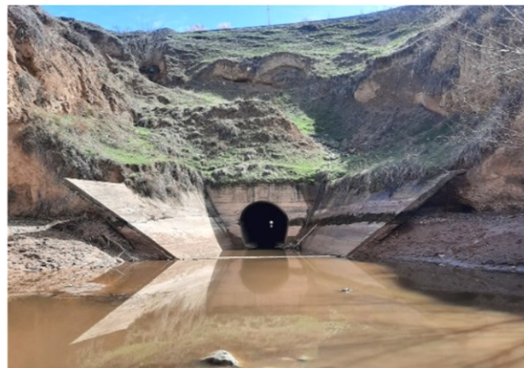
Рис 16. Вид на выходной портал и склон над ним.
