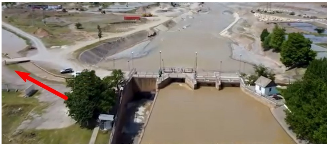
Рисунок 3. Головное водозаборное сооружение
